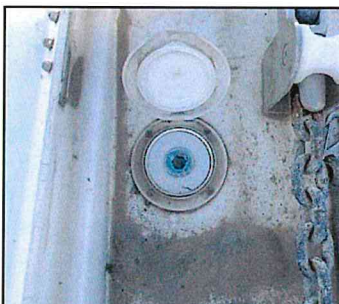
Photo 10 : prise d'eau corrodée
