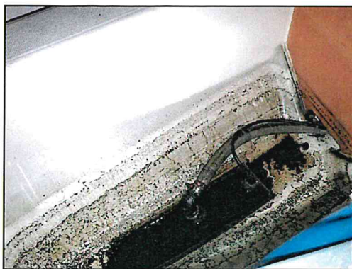
Photo 24 : cale cabine avant
